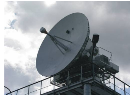
Полноповоротная антенна диаметром 4,7 метра С, Ки диапазоны.
