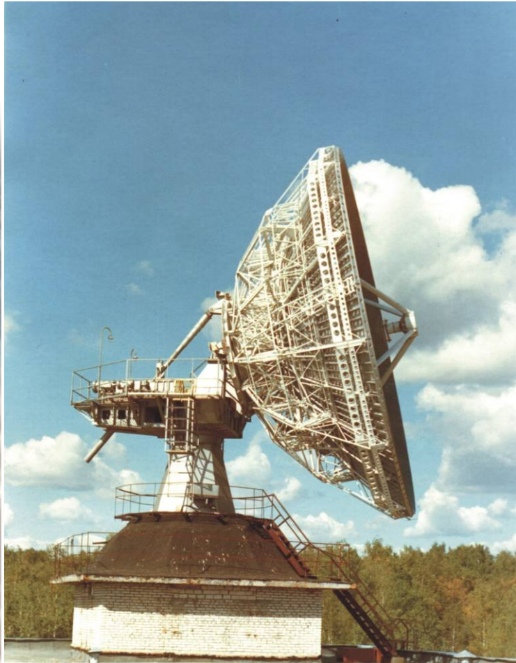
Полноповоротная антенна ТНА-57 диаметром 12 метров.
